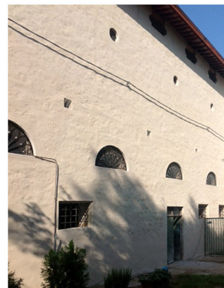
Facciata Nord, dopo l'intervento
