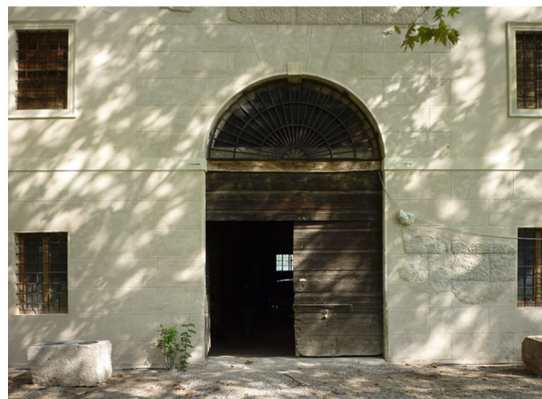
Portale d'accesso sulla facciata Sud; dopo l'intervento
