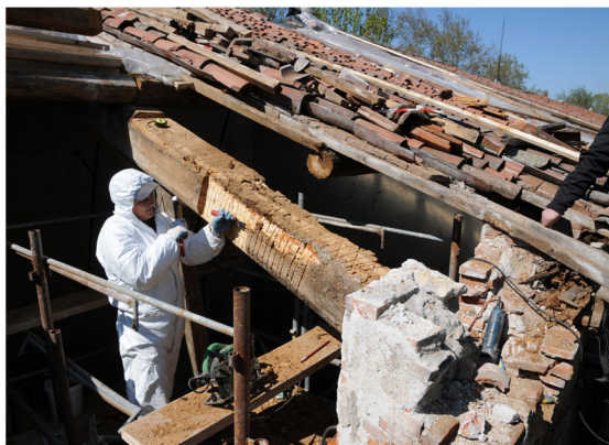
Intervento sulle travi e sulle capriate di copertura
