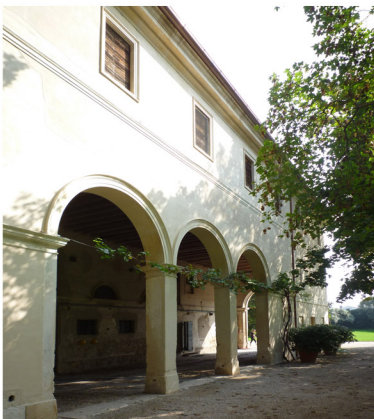
Facciata Sud, dopo l'intervento
